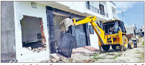
करनाल। अवैध निर्माण पर पीला पंजा चलता हुआ। फोटो: हरिभूमि
